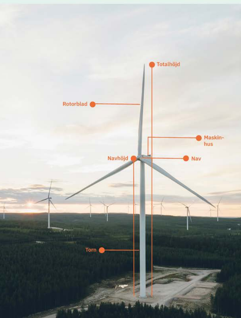
FIGUR 4 Principskiss av vindkraftverkets delar.
